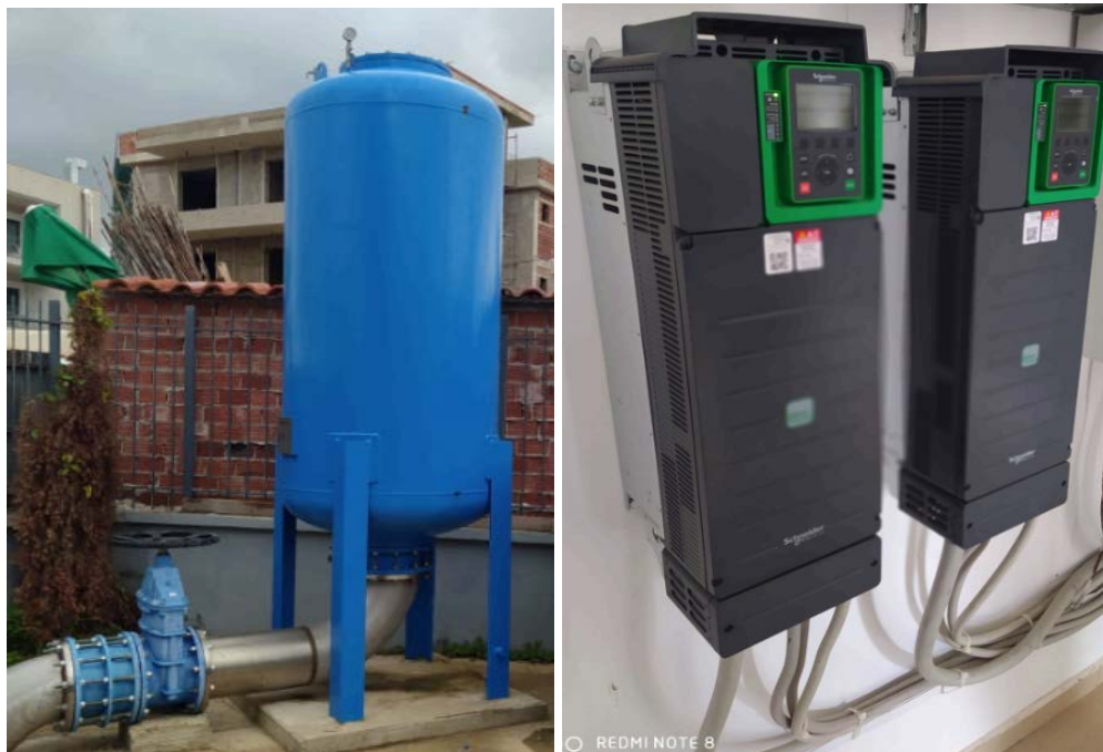
Figure 6–16 Instalimi i dhomes se ajrit dhe ndezesve te bute te pompave St. Nr.4
